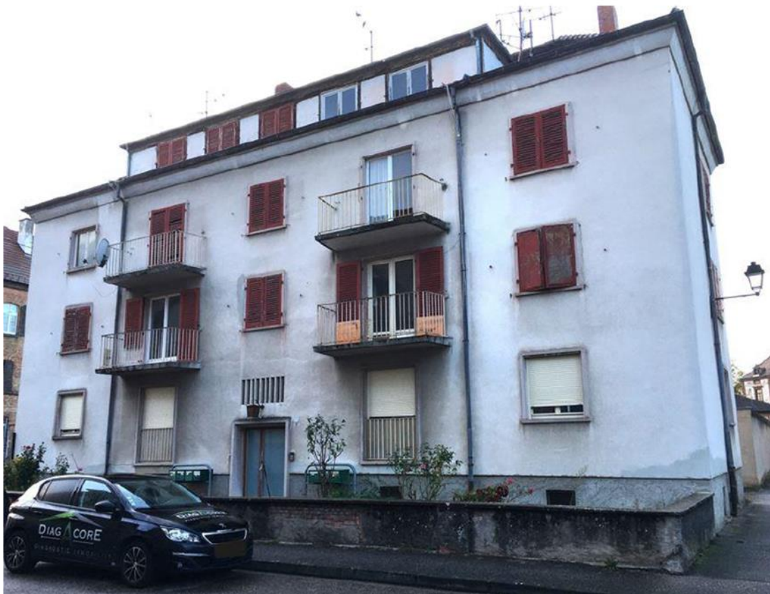
Façade Sud-Est de l'immeuble
